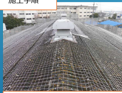
①踏抜墜落防止ネット敷込
