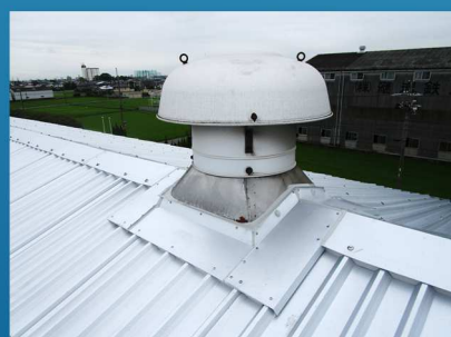
⑦棟部・ルーファ廻り板金納め
