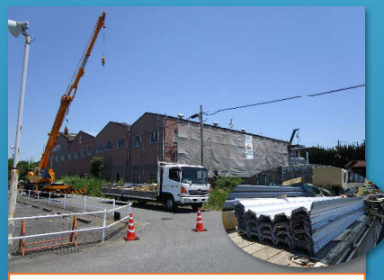
③屋根上荷揚げレッカー作業
