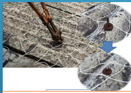
②既設フック材の余長切断
